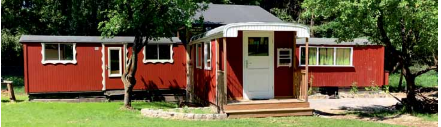
Der Waldkindergarten wird ständig erweitert. Der dritte Bauwagen dient als Büro.
